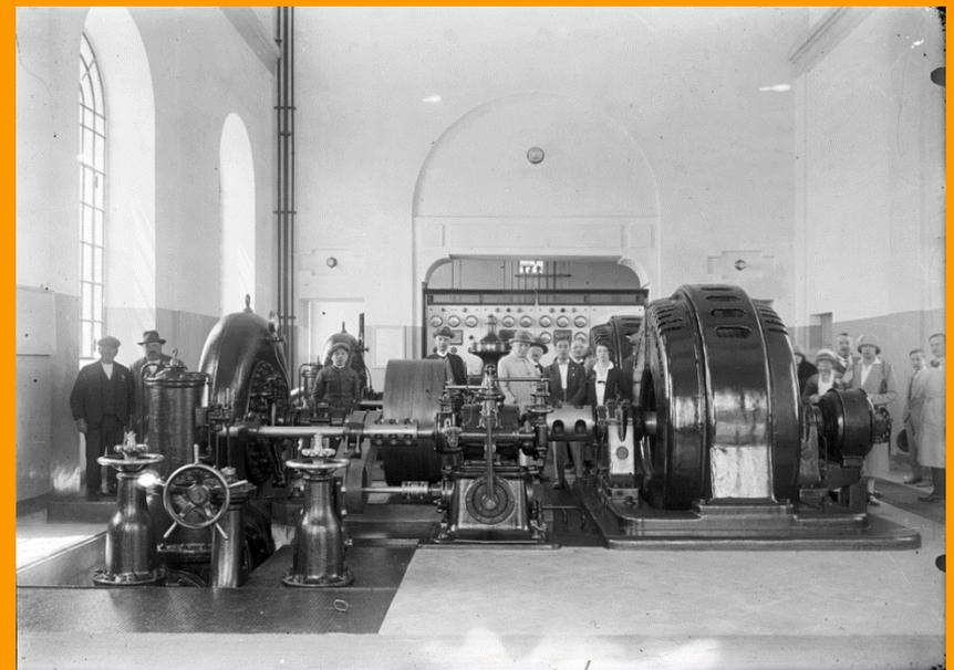
**Turbine idrauliche ad asse orizzontale, tipo *Francis* in camera forzata a spirale, della Ditta "Costruzioni Meccaniche Riva".**
