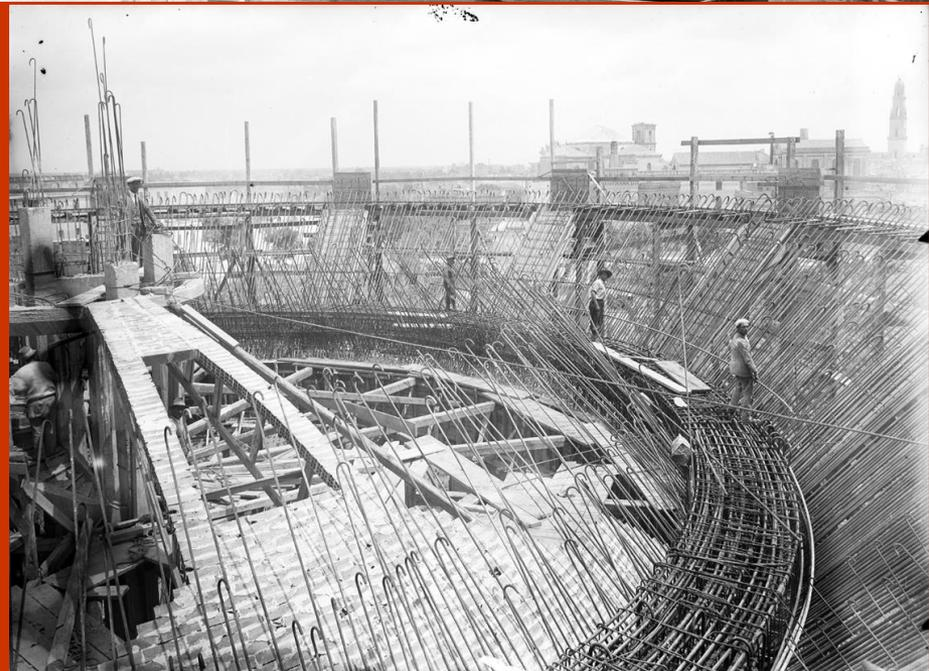
Il **serbatoio** ha un diametro di circa 2500 metri e un'altezza totale pari a 28.
